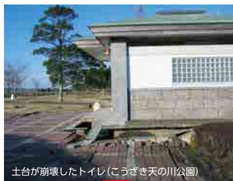
液状化で川底から土砂が噴き出し、ブロック タイルは崩壊 (こうざき天の川公園)
