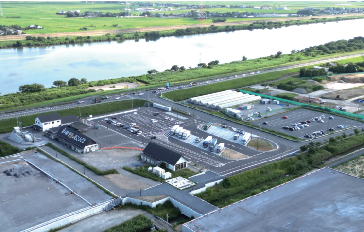
▲造成工事が進む道の駅改修土木工事
