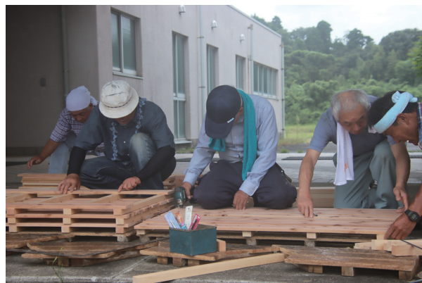
▲新しい渡り板を作成（神崎小学校）
