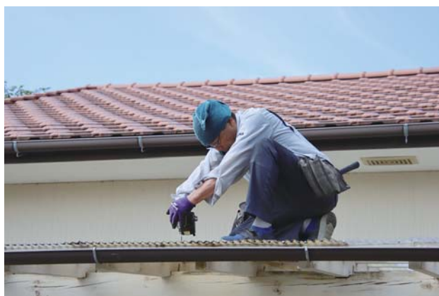
傷んだ屋根の交換作業（神崎中学校）
