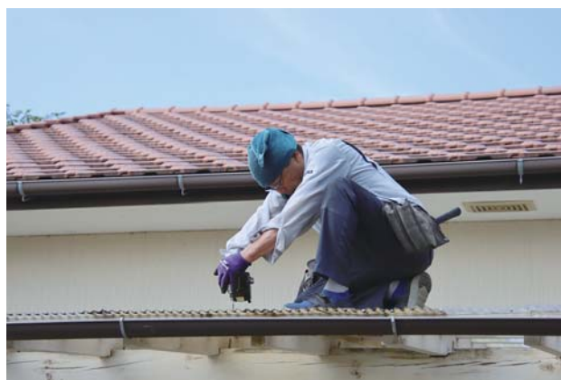
傷んだ屋根の交換作業（神崎中学校）
