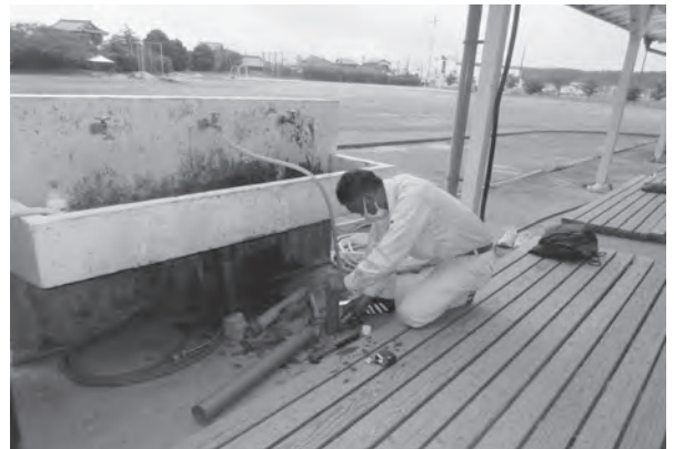
水漏れがある排水管を修繕（神崎中）
