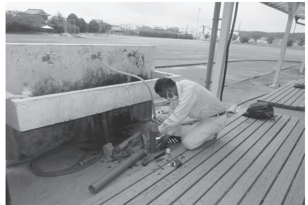
水漏れがある排水管を修繕（神崎中）
