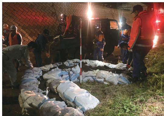
利根川堤防で行われた月の輪工法による水防活動
