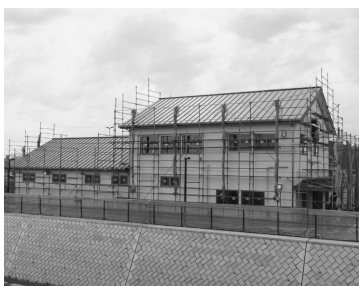
建設中の新しい新鮮市場
