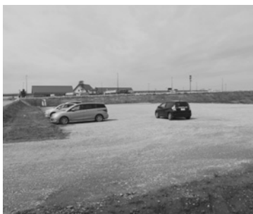
今年度舗装予定の「道の駅第2駐車場」
