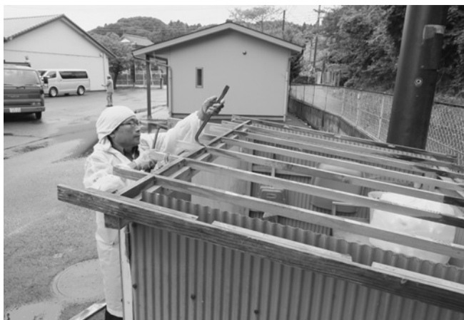
雨漏りがあった中学校のゴミ置き場の屋根を修繕
