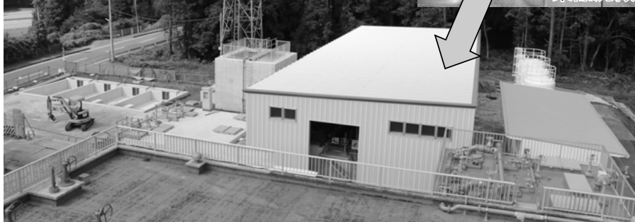
薬品沈殿池（建物内）
