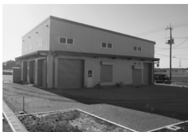
(導水ポンプ場：小松地先)
