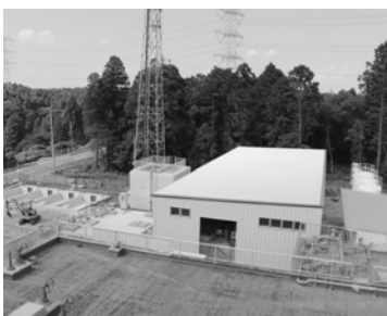
4月1日から新しい浄水場が運転します。
