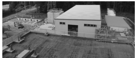
浄水場移転工事の様子
