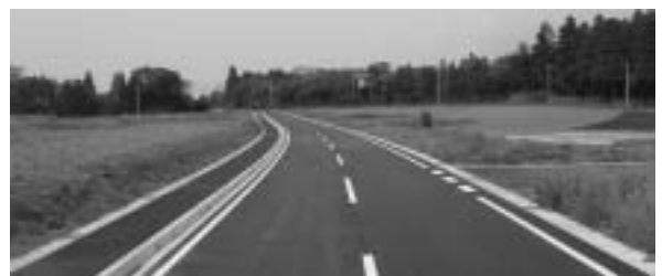
全線開通の町道武田古原線
