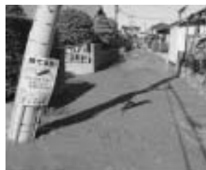
液状化による被害
