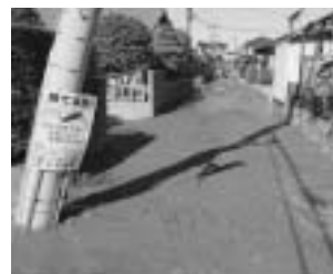
液状化による被害
