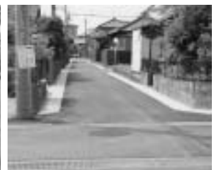
復旧後の様子
