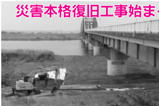
神崎大橋は12月末の一部開通を目指して工が進みます。
