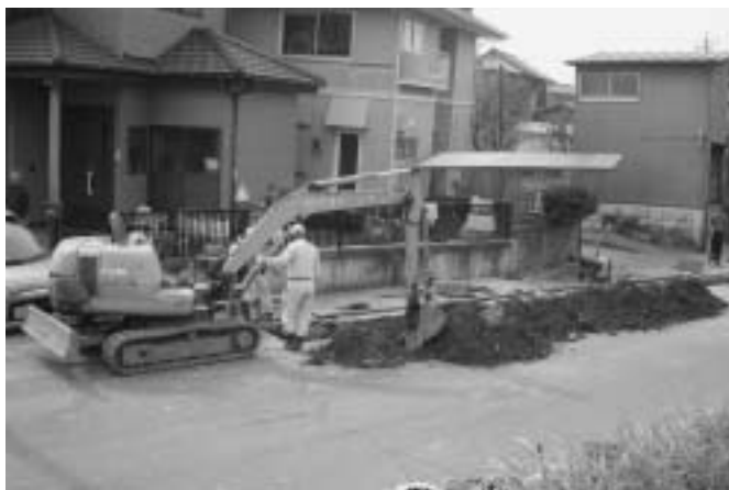
水道管の埋設が始まりました。
