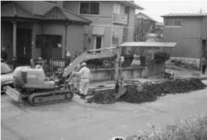
水道管の埋設が始まりました。
