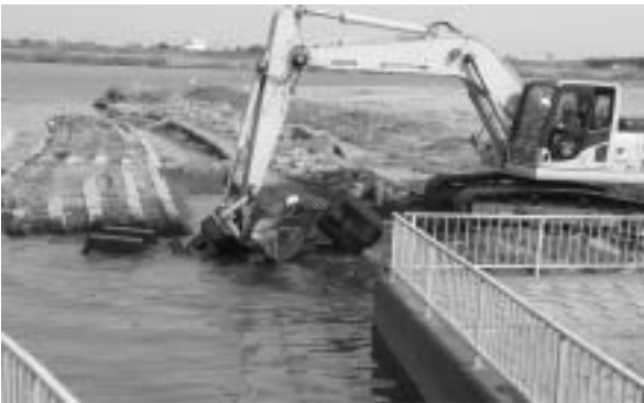
榎さんは、神崎樋管 応急作業をボランティア
