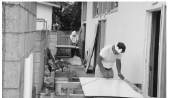
神崎小学校プール扉の張り替え作業
