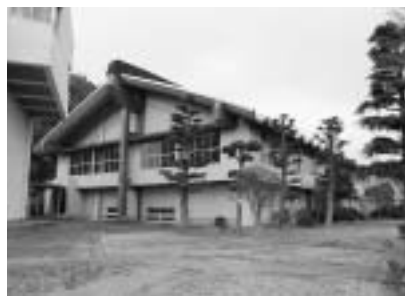
耐震工事が行われる神崎中学校屋内運動場
