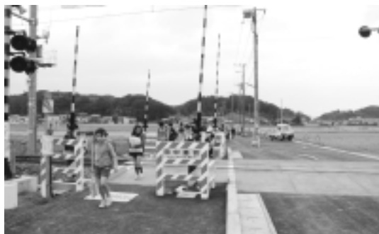
平成20年12月田中踏切拡幅工事が終了した町道並木郡根岸線
