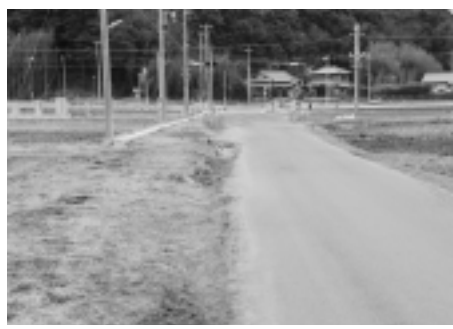
道路改良が進められている町道並木郡根岸線
