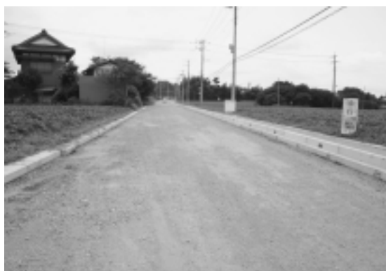
町道武田古原線（期）道路改良事業の実施状況
