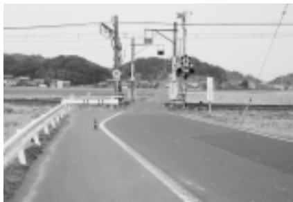
田中踏切付近の道路改良が行われる町道並木郡根岸線
