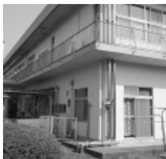
交換した給水管
