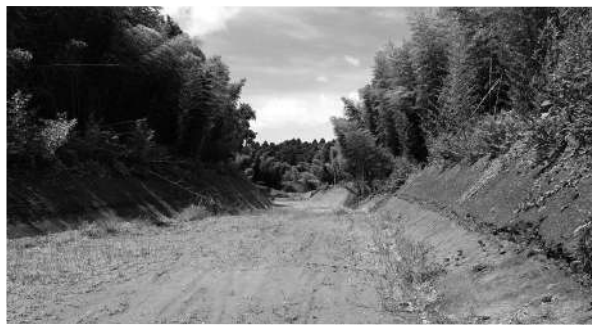
切土、盛土工事が進む成田神崎線
