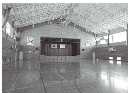
断熱加工が必要になる内部
