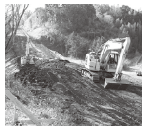
現在進行中の工事
