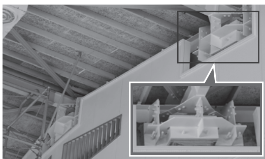
耐震工事後の体育館(天井)
