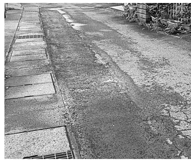
町道の舗装修繕(本宿3区)
