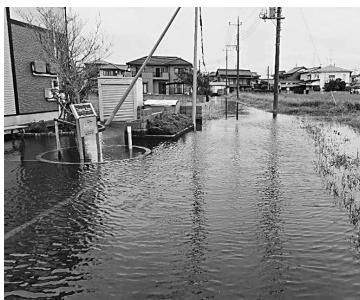
冠水した町道(神宿区)
