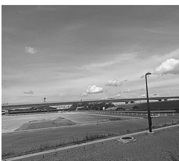
工事が進む神崎PA（仮称）
