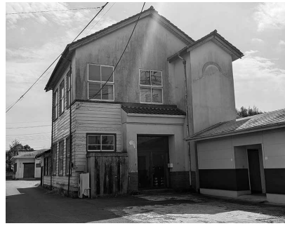
解体予定の旧役場庁舎
