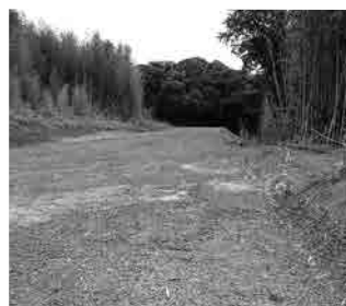
切土工事が進む 成田神崎線
