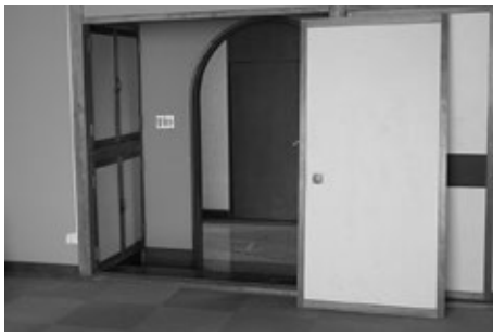
段差が解消される役場1階小会議室
