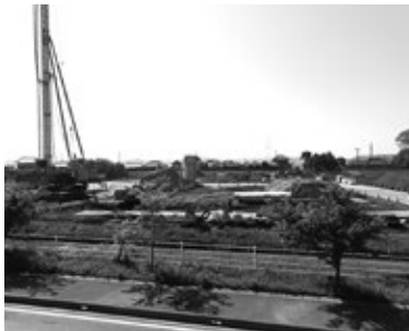
進む神崎PA工事
