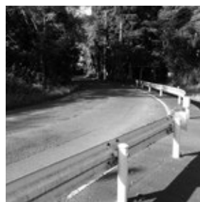
改修予定の町道 大貫武田線
