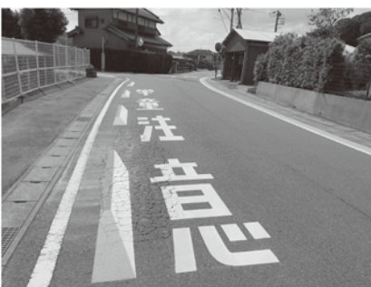
通学路緊急点検で整備された町道
