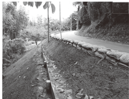
大雨で崩落した町道の復旧工事
