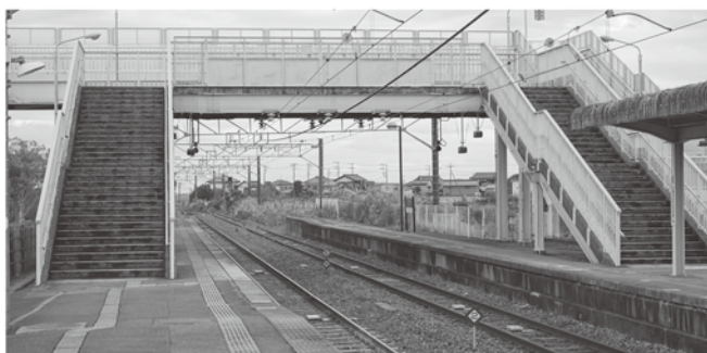
ホーム内の跨線橋
