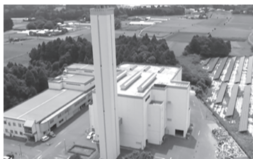
伊地山クリーンセンター
