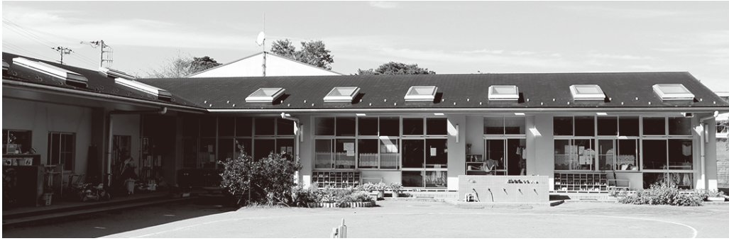
増築予定の米沢保育所
