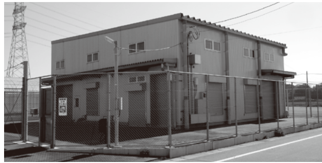
導水ポンプ場
