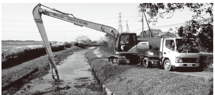
天の川公園・浚渫工事
