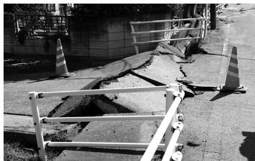
地震による被害(液状化)
