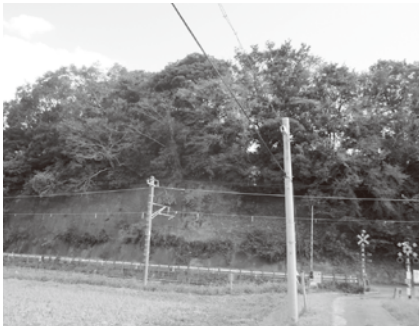
並木田向根地先・法面
