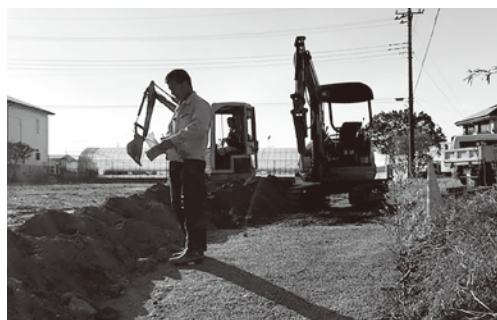
愛宕山の工事
