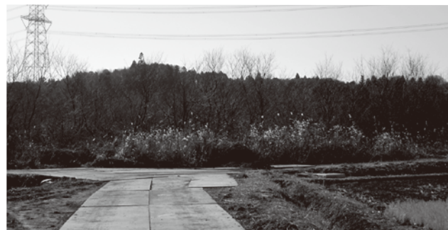
流末排水路周辺
