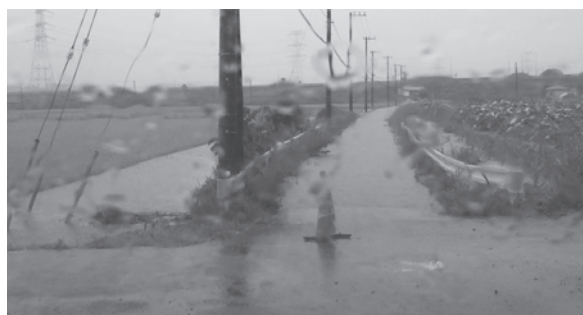
冠水した道路(松崎地先)
