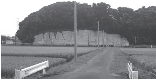
法面修繕箇所(並木地先)
