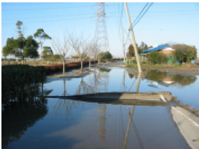
天の川公園道路液状化
