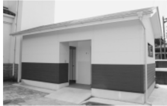
多目的トイレも装備した 水洗トイレ
