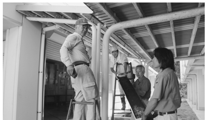
神崎小学校体育館と給食センターの間の雨どいを修繕
