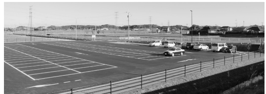
道の駅第2駐車場整備事業
