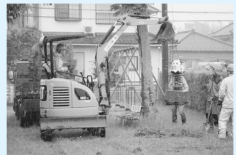
プラザ脇の危険遊具を撤去
