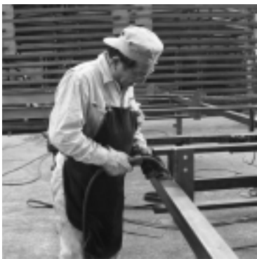
溶接作業をする金山さん
