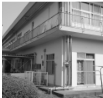
交換した給水管
